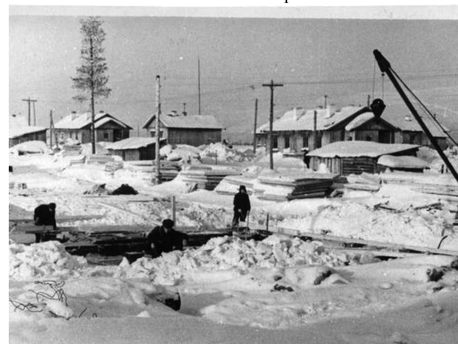
Строительные работы в поселке Апатиты
