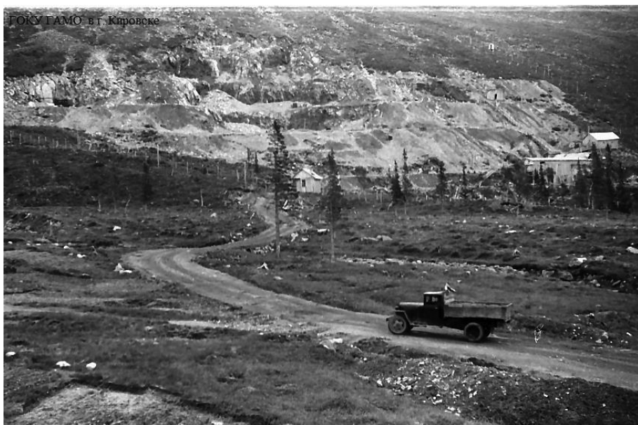
Промплощадка хибинитового карьера. Фото 1951 г. (из фондов ГОКУ ГАМО в г. Кировске)
