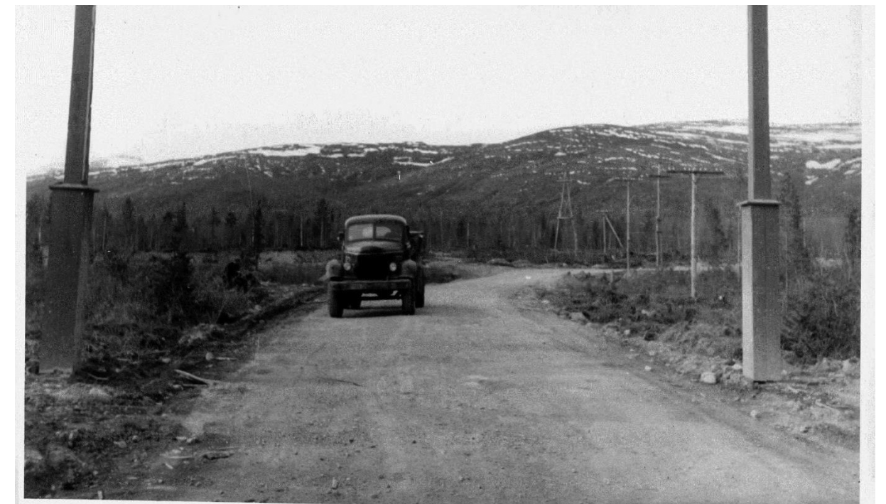
Начало строительства АНОФ-2
